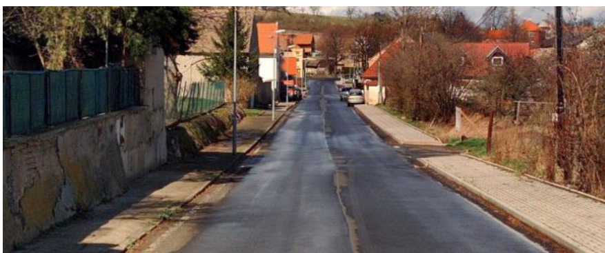
Silnice III/2492 v jižní části obce Děčany vybavená chodníky.
