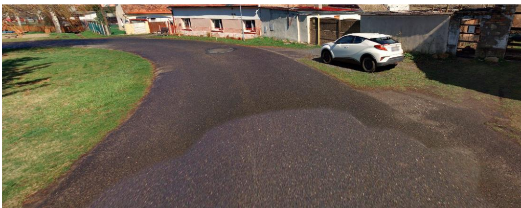
Místní komunikace v centrální části sídla Lukohořany.
