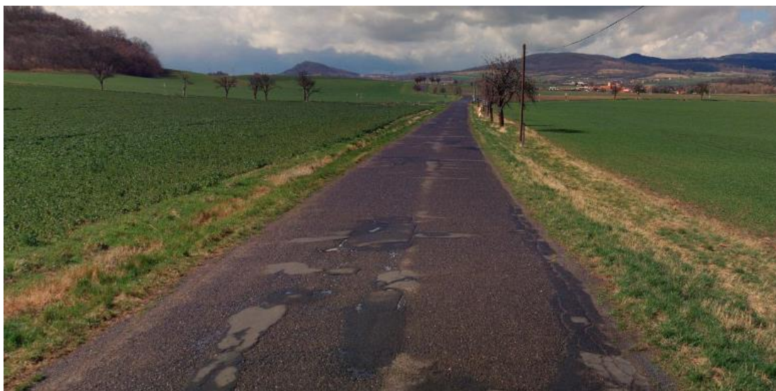
Silnice III/2465 v jižní části k.ú. Solany.
