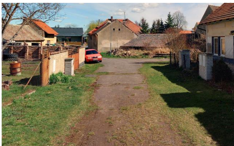
Místní komunikace v severozápadní části sídla Solany.
