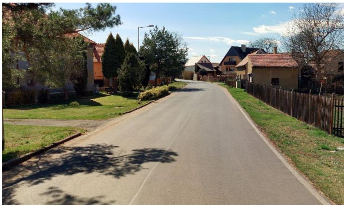
Silnice III/2492 v jižní části sídla Solany.
