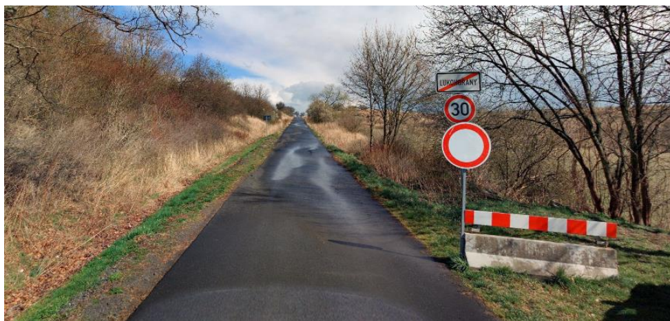
Silnice III/23753 v severovýchodní části sídla Lukohořany.
