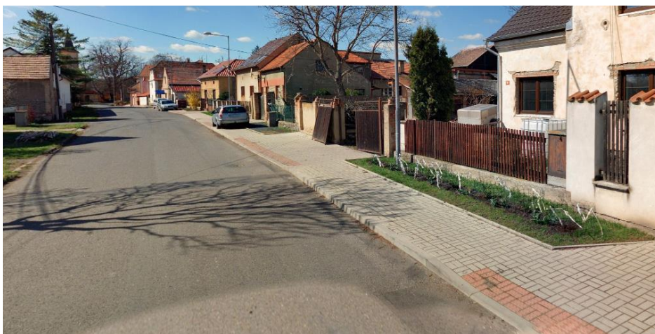
Silnice III/23752 ve východní části sídla Solany vybavená chodníky.
