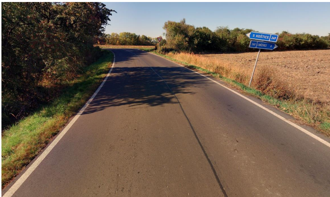
Silnice III/2492 jižně od obce Děčany, kde se napojuje na silnici II/249.
