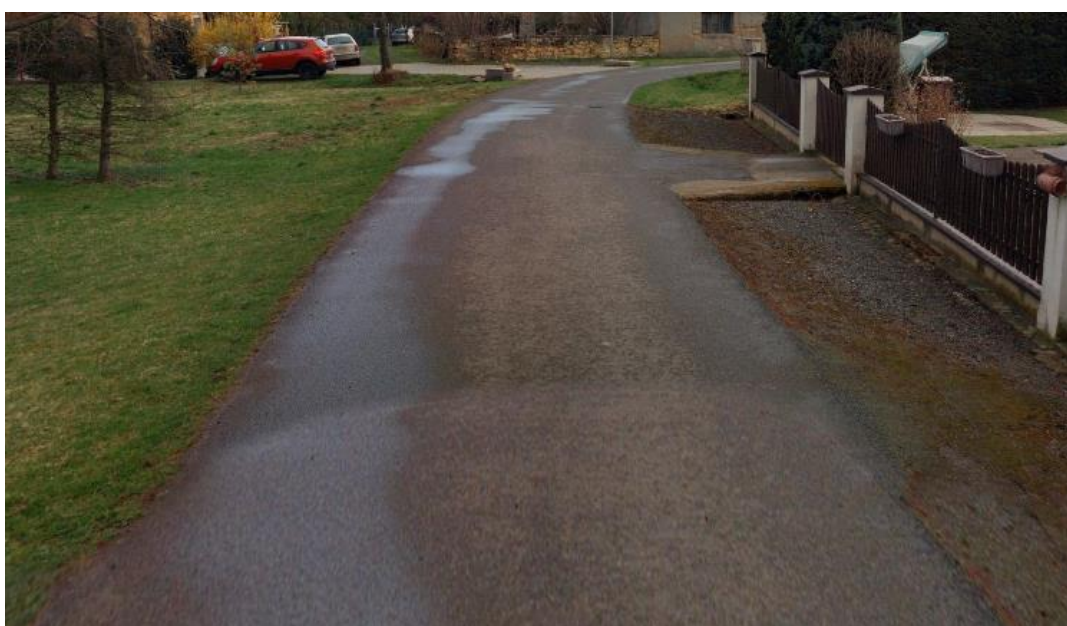
Místní komunikace v jižní části sídla Semeč.
