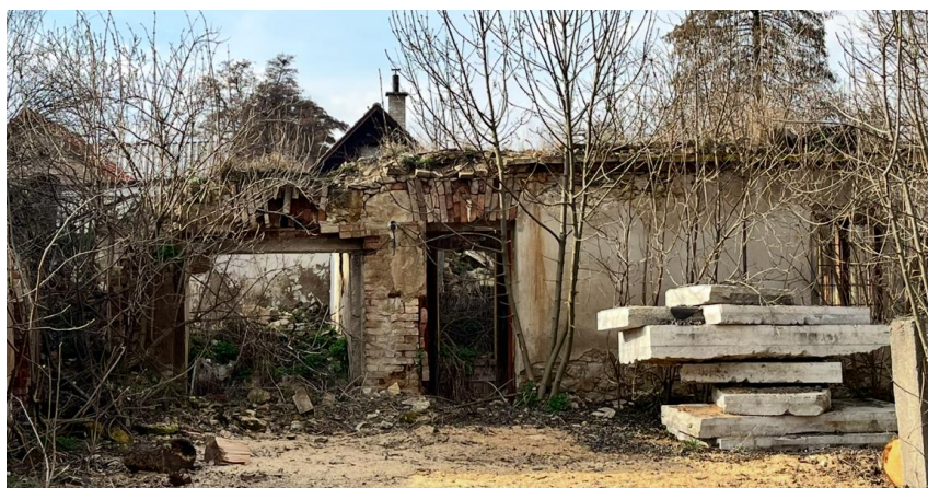
Zbořeniště v jižní části sídla Semeč určené pro přestavbu na plochu „Smíšené obytné venkovské“ (SV).
