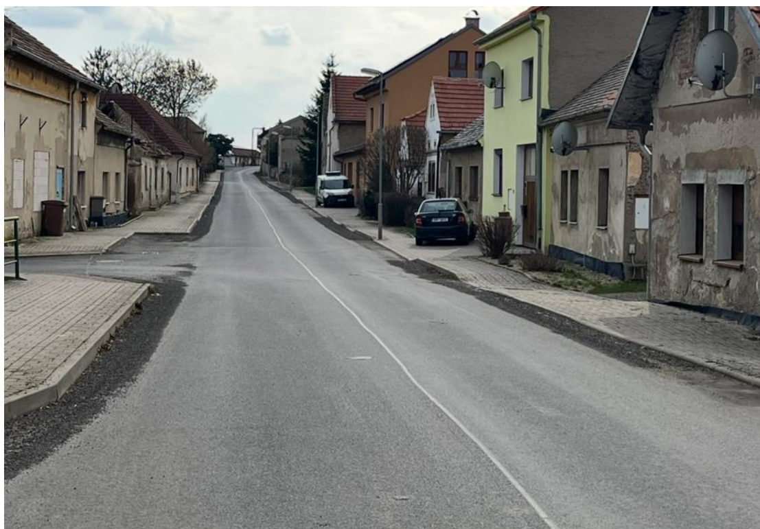
Silnice III/2492 v centru obce Děčany.
