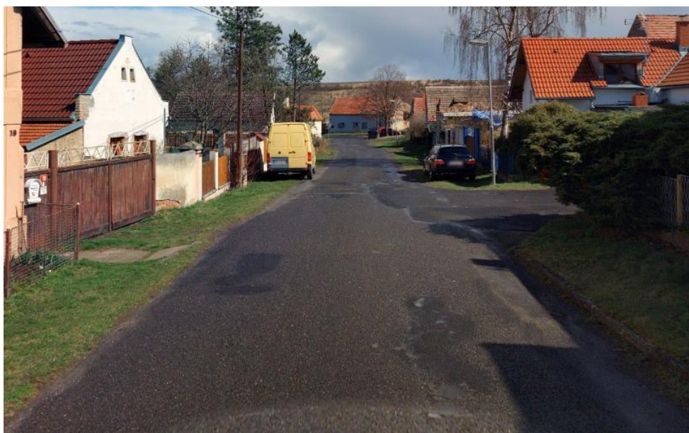
Silnice III/23753 v centru sídla Lukohořany.
