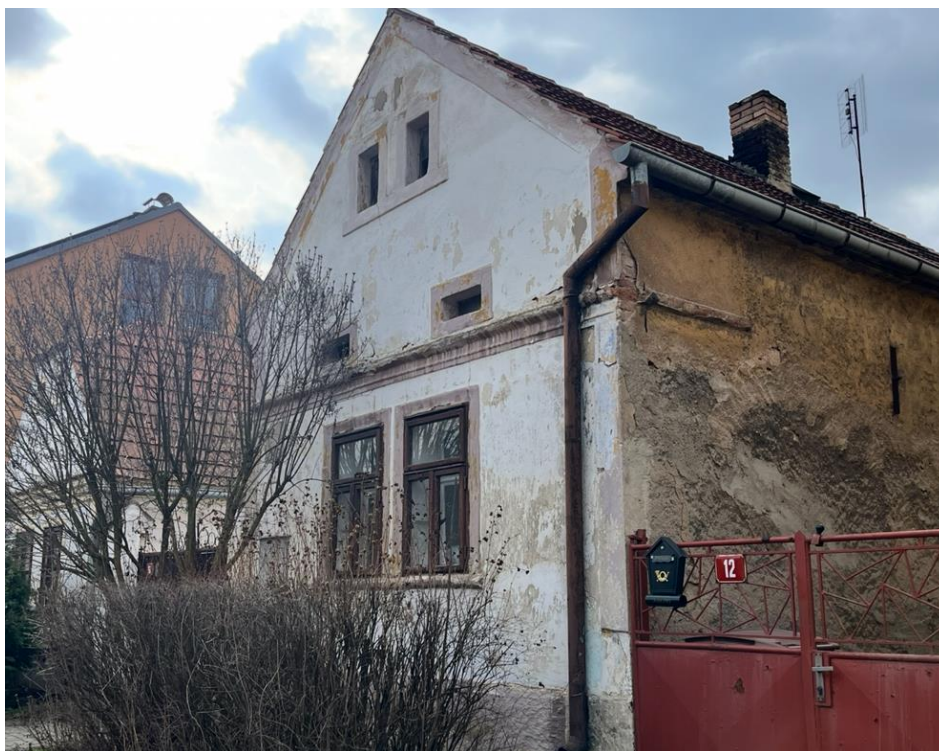
Individuální rodinný dům venkovského charakteru vyžadující rekonstrukci.
