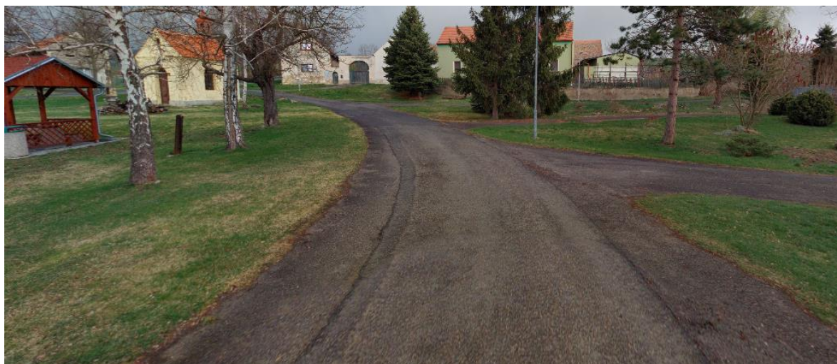
Místní komunikace v centrální části sídla Semeč.
